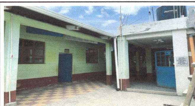
Foto 3: Sustitución de canal de PVC + Reparación de bajada de agua pluvial, tubo PVC 3"
