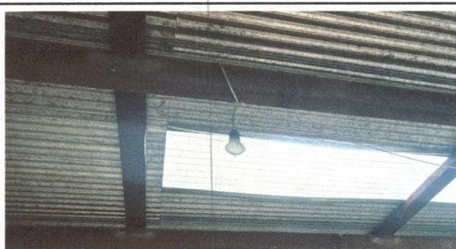
Foto 4: Sustitución de focos ahorradores + Sustitución de plafoneras
